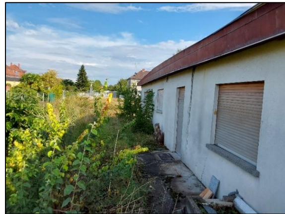
Abb. 3: Südansicht des alten Wohngebäudes mit Ruderalvegetation und Jungaufwuchs.
