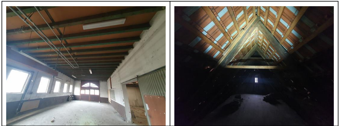
Abbildung 18: Blick in angebaute Lagerhalle (links) und zugehörigen Dachbereich
