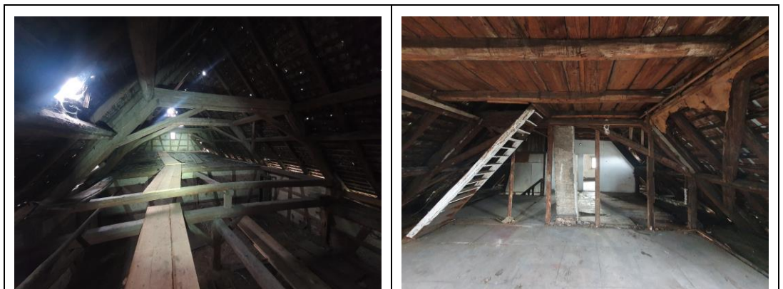
Abbildung 19: Blick in Dachbereiche des alten Wirtshauses
