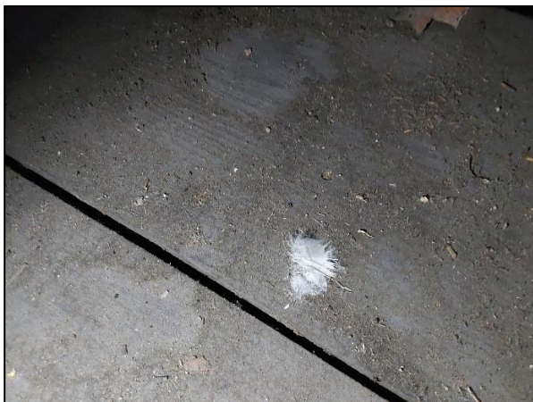
Abb. 6: Federn im Dachstuhl des Gasthofs „Hechten“.
