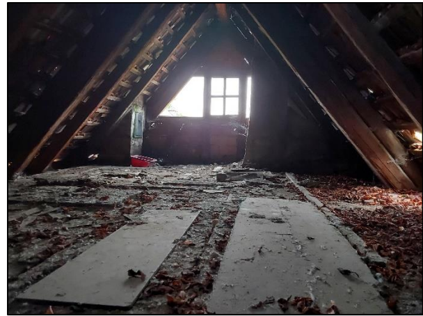
Abb. 9: Dachstuhl eines Nebengebäudes mit offenen Holzbalken.
