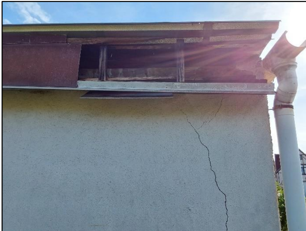
Abb. 10: Offene Traufe am alten Wohngebäude.
