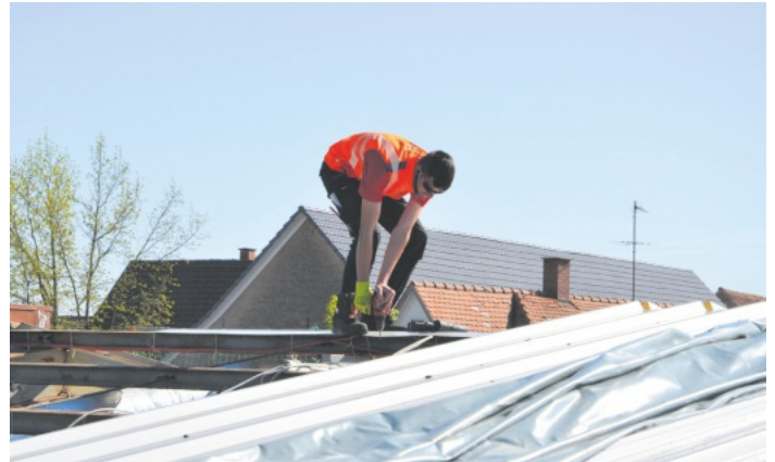
Auf dem Dach der Erwin-Maurer-Halle sollen nach der energetischen Sanierung Photovoltaik-Module installiert werden. Foto: Stadt Kehl
