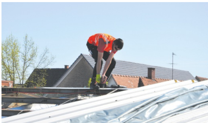
Auf dem Dach der Erwin-Maurer-Halle sollen nach der energetischen Sanierung Photovoltaik-Module installiert werden. Foto: Stadt Kehl/Mark Gregotsch
