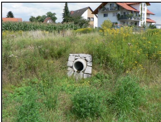
Bild 4: Einlauf Versickerungsmulde
